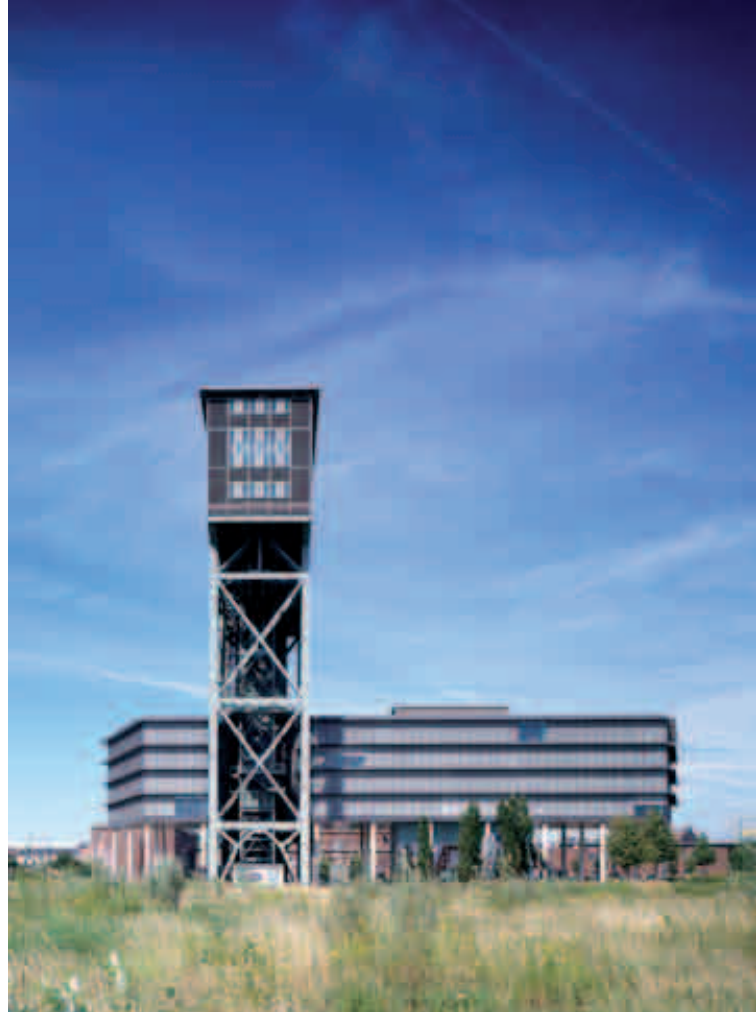
Umnutzung der ehemalige Zeche Minister Stein in Dortmund-Eving zum Zentrum Minister Stein für Wissenschaft, Beratung und Qualifizierung (ZMS) im Rahmen der Internationalen Bauausstellung Emscherpark (IBA) 1990
